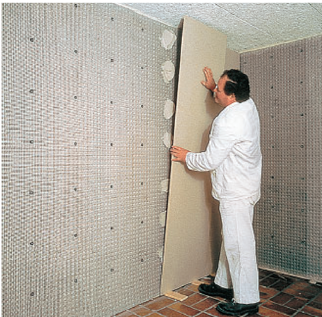
DELTA®-PT impermeável, suporte confiável para rebocos, placas de gesso ou outro tipo de acabamento.
